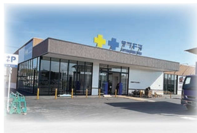
幸町地区コミュニティ施設 工事現場
