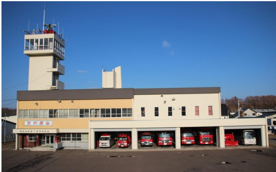
美幌・津別広域事務組合 津別消防庁舎撮影（平成30年7月現在）
